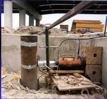
12.75" OD Steel Pipe Pile
