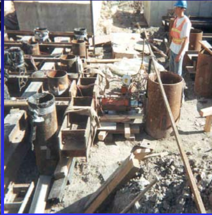
24" OD Steel Pipe Pile
